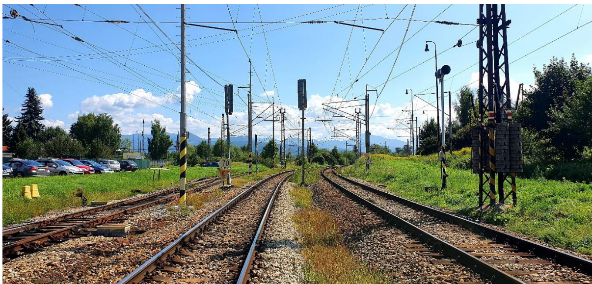
Výkon ŠOD zameraný na kontrolu osadenia návěstidiel na trvalé obmedzenie traťovej rýchlosti a návěstidiel pre elektrickú prevádzku, Zdroj: Ing. Matej Šurin
